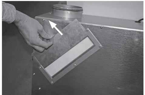
Jetzt können die Profi-Aktivkohlefilter P 220 eingesetzt werden. Anschließend Filterdeckel wieder einschieben.
